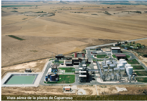
Vista aérea de la planta de Caparroso
